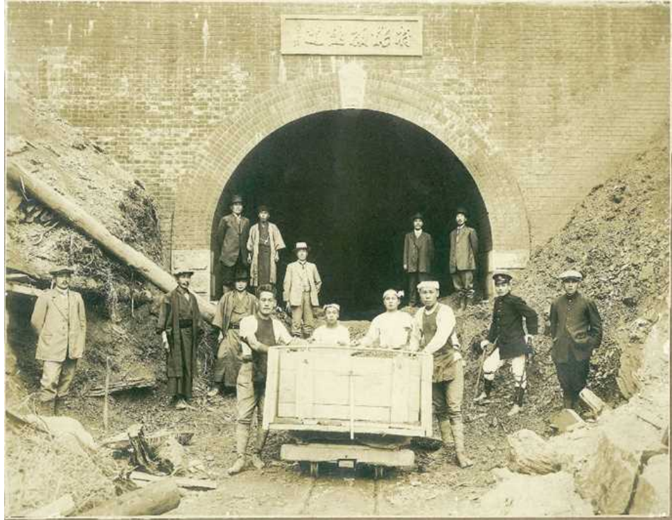
府能隧道 大正11年（1922） 上部には「府能嶺隧道」の銘板
