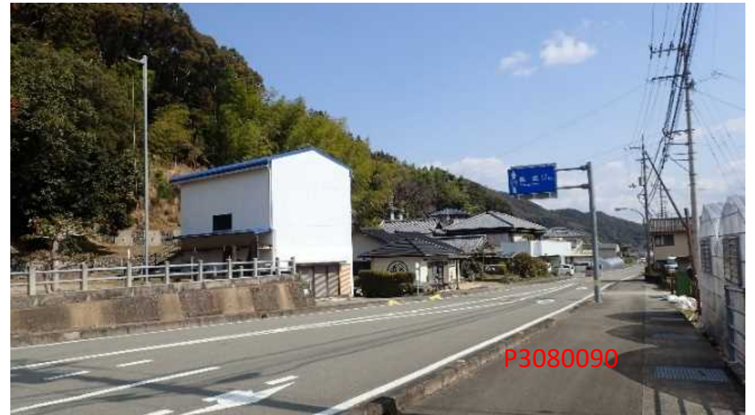
朝宮神社の東側 国道439号 2024年3月8日撮影 小学校跡地には青年会館が建てられていた
