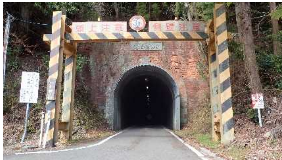
府能隧道 2024年3月8日撮影 府能側
