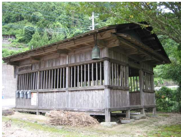
古井の地藏堂 切妻屋根 美郷では三方開放型が多い がここは、腰長押から内法長押まで縦格子 三間堂(美郷村2003)
