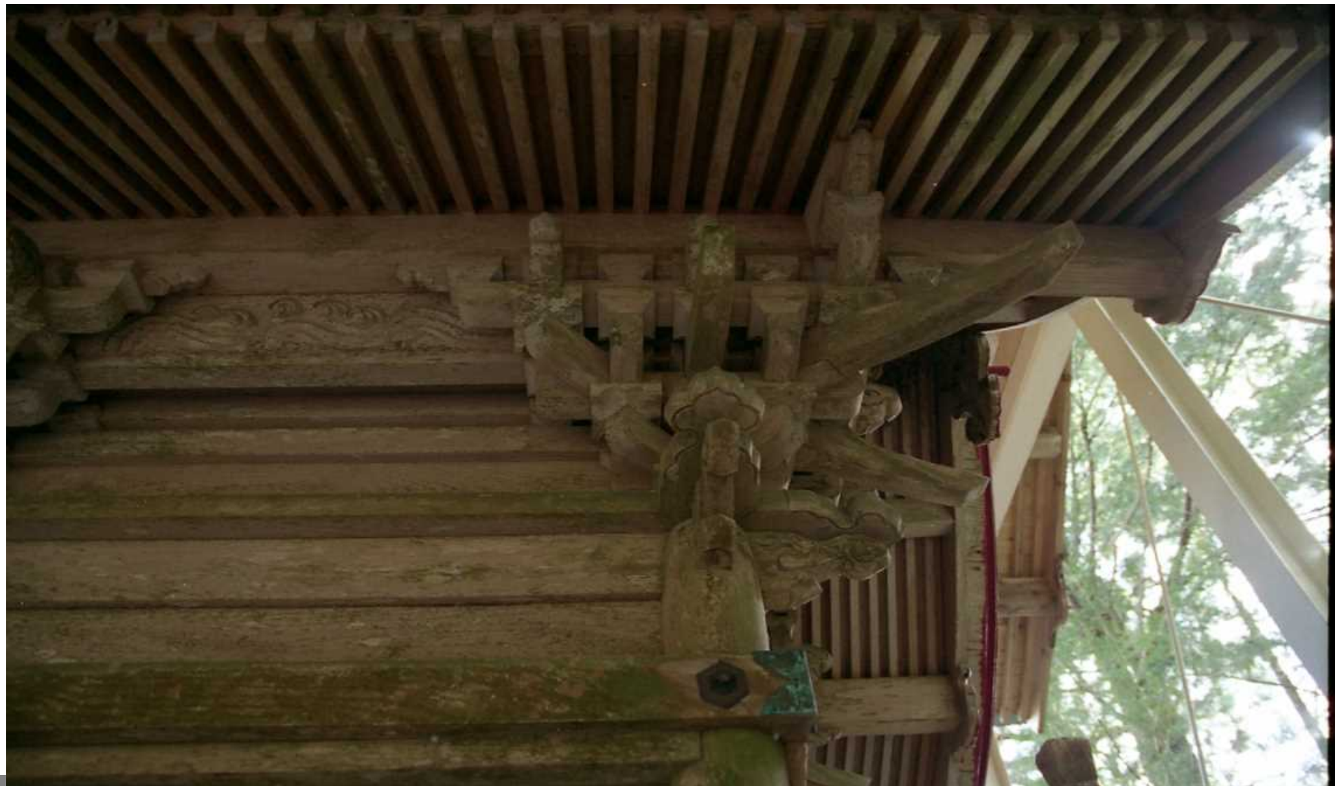
木沢村 掛盤の八幡神社本殿
