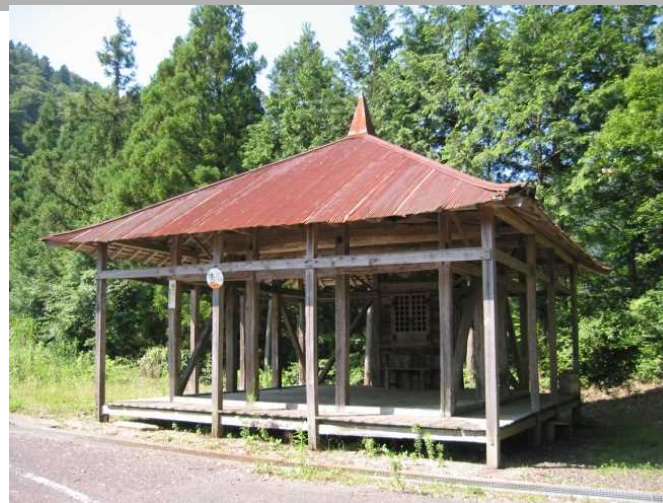
横石堂 方三間宝形造 三方吹きさらし三間堂(木屋平村 貢2007)
