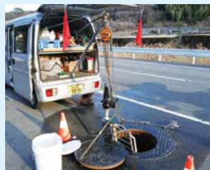
マンホールからポンプを引き上げる作業
