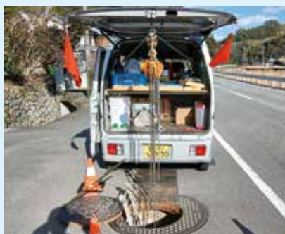
作業中の通行制限の状況
