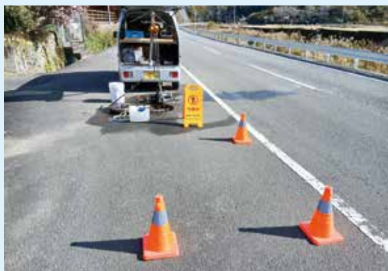
作業中の通行制限の状況
