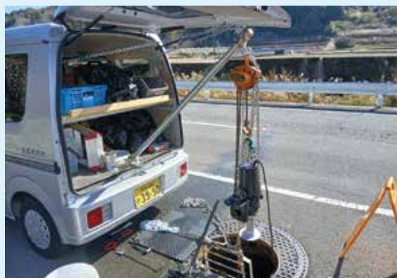
マンホールからポンプを引き上げる作業
