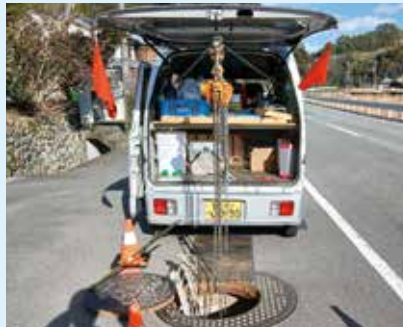
作業中の通行制限の状況
