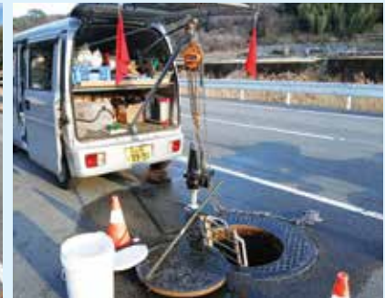
マンホールからポンプを引き上げる作業
