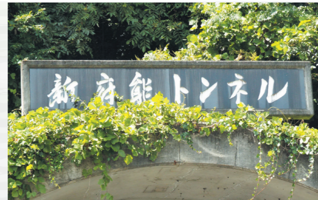
新府能トンネル銘板
