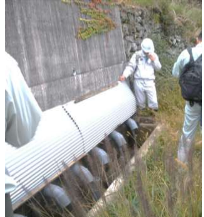
地下水を抜くためのボーリング孔 (徳島県三好市)
