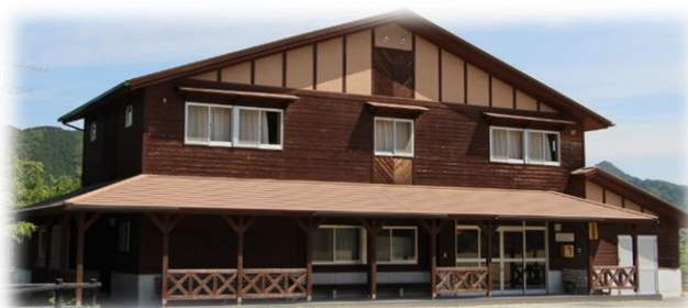
中央運動公園管理棟
