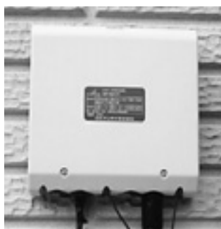
設置済みの光電変換器（ONU）
