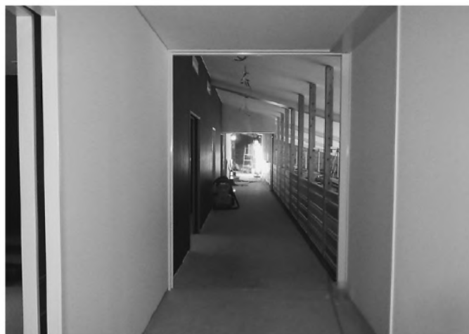
2階内装工事の状況
