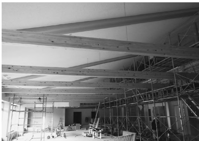
1階事務室の内装工事の状況
