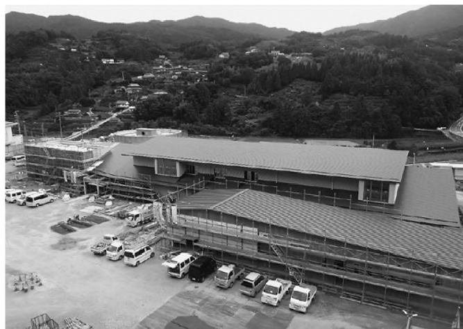
北西から見た全体の状況
